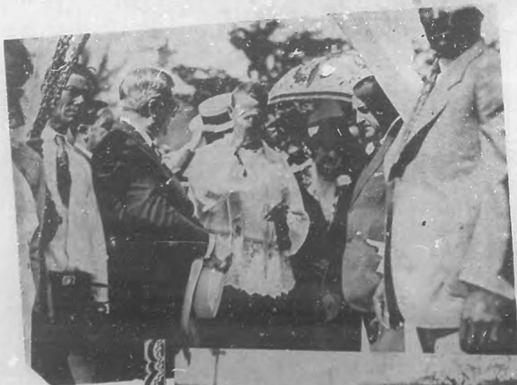
El Rvdo. Padre Monighan bendiciendo la primera piedra del edificio para Clínica Antituberculosa que se va a construir en terrenos del sanatorio "La Esperanza".
